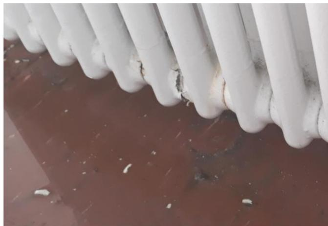
Dieser befindet sich in einem kleinen Zwischenraum hinter einer nachträglich eingebauten Kühlzelle neben dem Büro des Küchenchefs. Dort blieb er so lange unbemerkt, bis er eingefror, platzte und Heizungswasser zunächst unbemerkt bis in die Wäscherei-Decke sickerte. Dort ist es ja oberhalb der Mangel immer recht warm. So hoffen wir, dass der Schaden bald getrocknet ist. (24.02.; Scupin)
